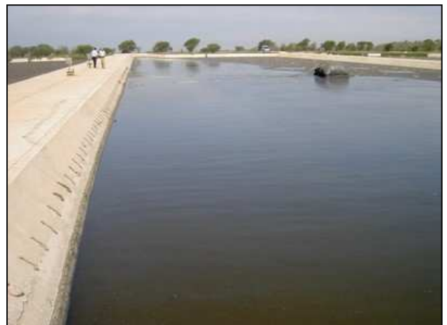
Bassin de décantation anaérobie de la STEP de M'Zar
