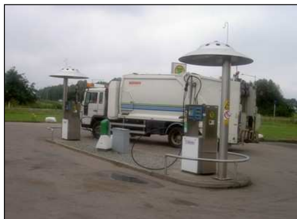
Station d'approvisionnement en biogaz-carburant de l'ins- tallation d'Helsingborg
