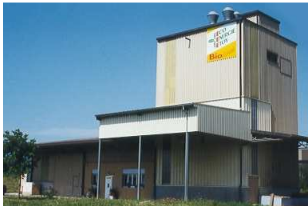
Installation de production de biodiesel Eco Energy Etoy (VD)
