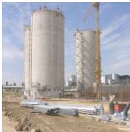
Construction des digesteurs
