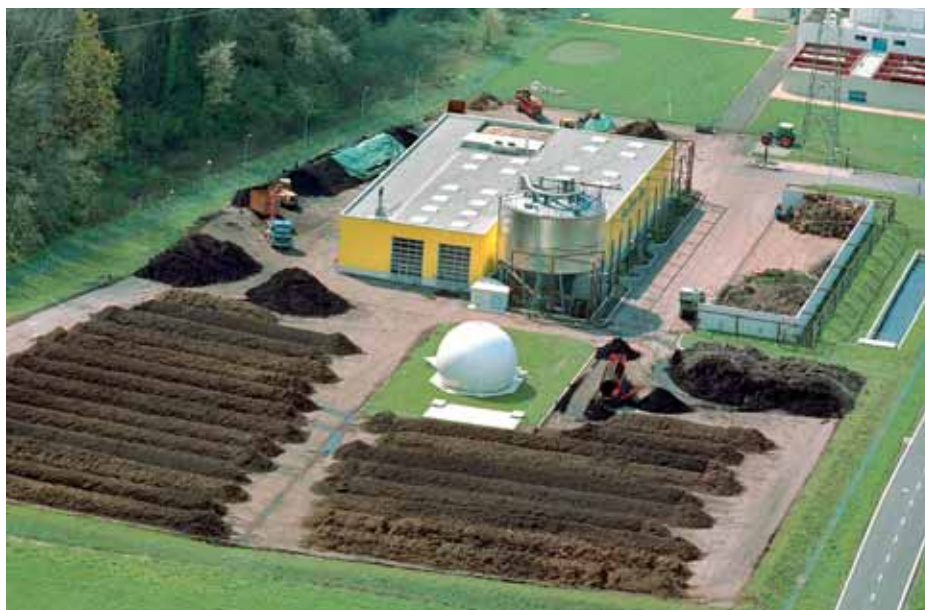
Vue aérienne de l'ensemble qui comporte le stockage du compost en andains (avant-plan), le réservoir de gaz et l'usine avec son silo.
